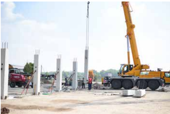
Die Arbeiten am Benningsweg haben begonnen.
