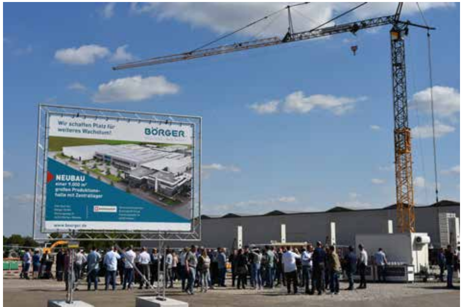
Ein großes Transparent informiert über das Bauprojekt.
